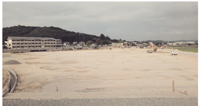
校庭拡張工事が進む第二中学校（H29.6.27現在）
